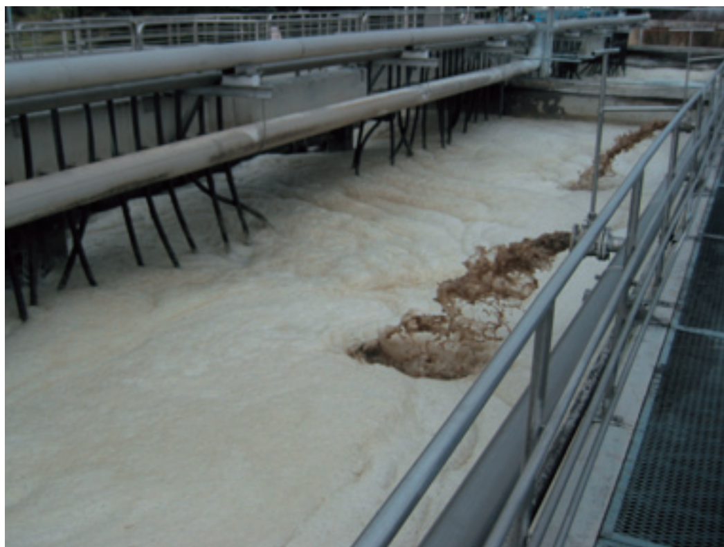
Slika 6: Posnetki prezračevalnega bazena ČČN s penami
