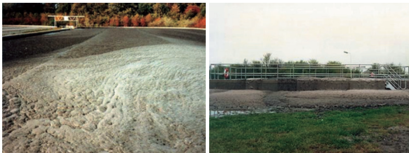
Slika 2: Težave zaradi čezmerne razrasti nitastih bakterij (vir: http://www.asissludge.com )
