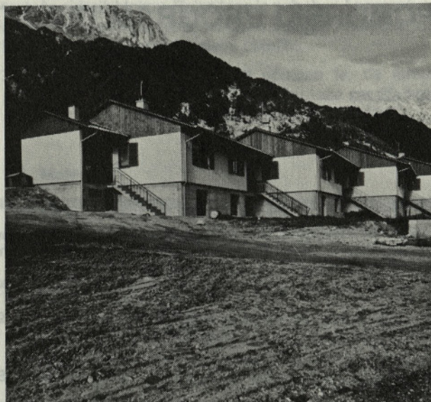
9. Montažni stanovanjski objekti v Beneški Sloveniji
