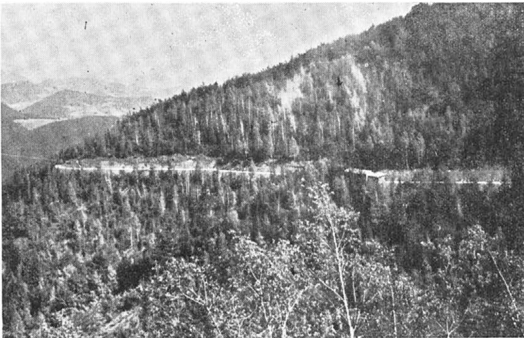
Gradnja gozdne ceste Črna-Luča čez Belo peč.
