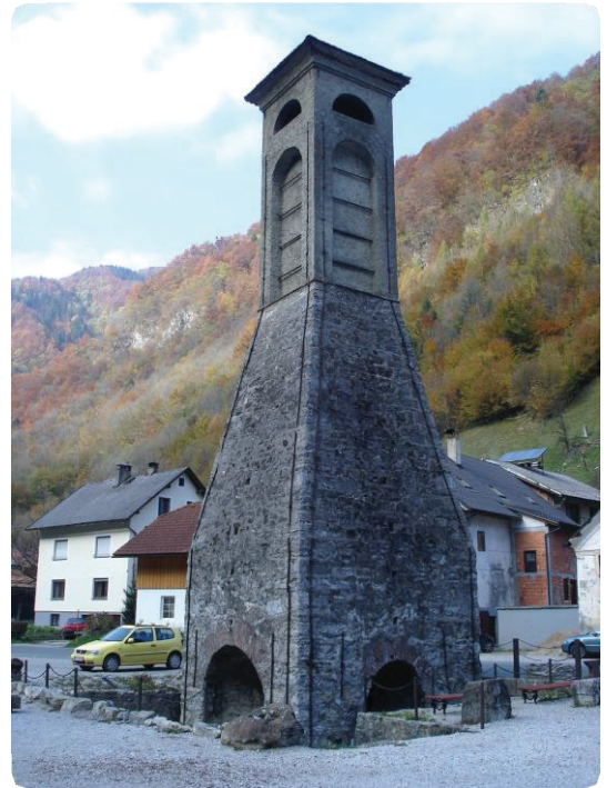
Železnikiben megtekinthető a jó állapotban fennmaradt nagyolvasztó kemence
