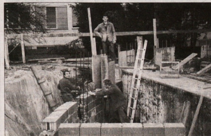
ZUNANJA DELA - Pod vhodom (na sliki) in v kleti novega dializnega centra je bila včasih stara kurilnica, sedaj pa bo tu prostor za pripravo dializne vode in popravilo aparatur, skladišče in večnamenski prostor Društva ledvičnih bolnikov Dolenjske. (Foto: M. Žnidaršič)
