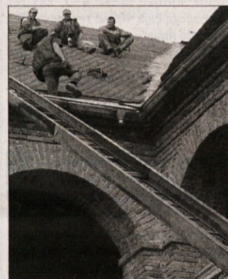
OBNOVA STREHE - Prejšnji teden so prekrili z novo strešno opeko streho nekdanje samostanske cerkve v Kostanjevici, prvotnega stavbnega spomenika zgodnje gotike pri nas, v katerem Galerija Božidarja Jakca prireja odmevne likovne razstave, in s tem zaključili letošnji program obnove. (Foto: MiM)
