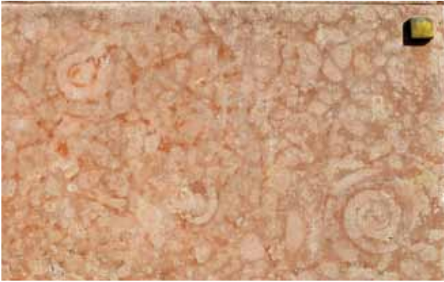
Vzdolžni preseki amonitnih hišic na fasadi Palače Deželne banke. Premer največje hišice je 21 centimetrov. Foto: Matevž Novak.
