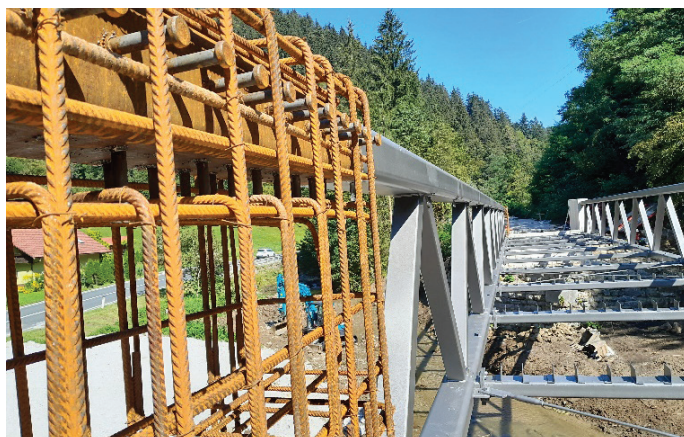
Slika 11. Detajl armature na krajnem oporniku mostu M2 čez reko Pako, avgust 2022.
