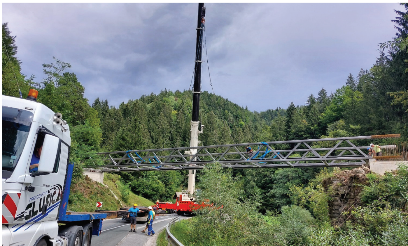
Slika 1. Montaža jeklene konstrukcije nadvoza N1 čez glavno cesto in Pako s pomočjo avtodvigala, avgust 2022.
