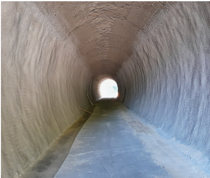
Slika 3. Sanacija obstoječega predora Paka 1, september 2022.
