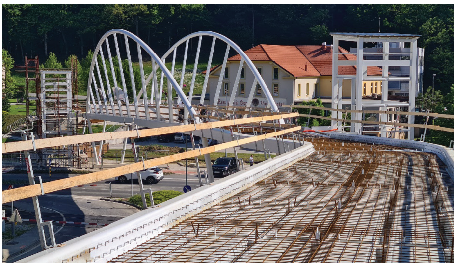
Sliki 16 in 17. Montaža jeklenih dvigalnih jaškov in armiranje voziščne plošče, maj 2022 (Foto: Ponting, d. o. o.).
