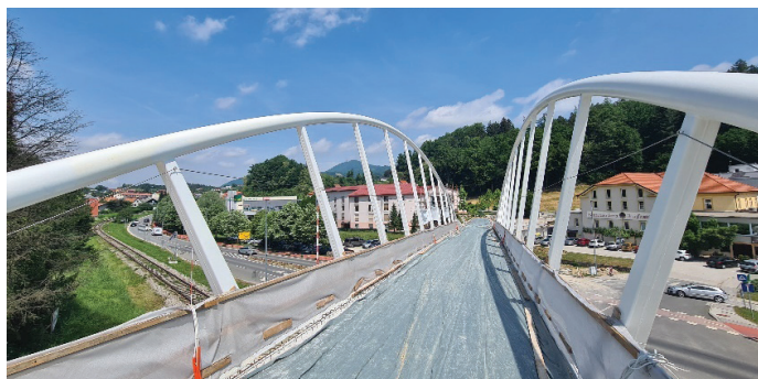
Sliki 18 in 19. Izvedba AB Hi-Bond-voziščne plošče, junij 2022 (Foto: Ponting, d. o. o.).
