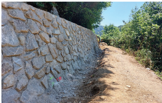
Slika 12. Izvedba novega podpornega zidu ob kolesarski poti, september 2022.
