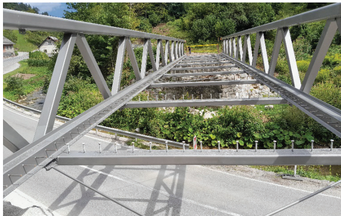
Slika 9. Jeklena konstrukcija nadvoza N2 čez glavno cesto in reko Pako, avgust 2022.
