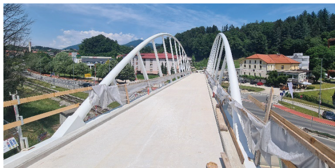
Sliki 18 in 19. Izvedba AB Hi-Bond-voziščne plošče, junij 2022 (Foto: Ponting, d. o. o.).
