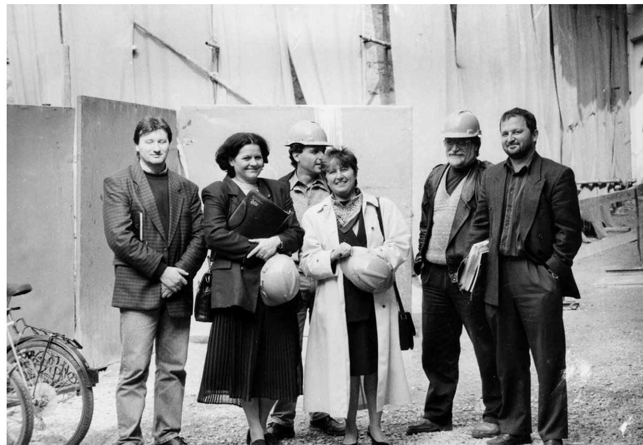
> Ravnateljica Lidija Majnik (druga iz leve), Kristina Šamperl Purg, vodja Oddelka za družbene dejavnosti Mestne občine Ptuj (na sredini), in arhitekt Marjan Berlič (drugi z desne) s predstavniki izvajalcev del na gradbišču Malega gradu, 1996 (foto: arhiv KIPP)
