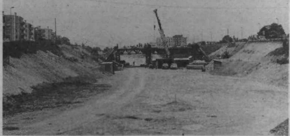
V gradnji pa je tudi nadvoz nad severno obvoznico v podaljku Hošimihove ceste, ki bo dolg 55 metrov, širok 16 metrov in bo imel na obeh straneh pločnik. Predvidevajo, da bo dograjen do konca oktobra.
