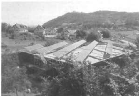
94. Sončna elektrarna v Kamniku pod Krimom.
