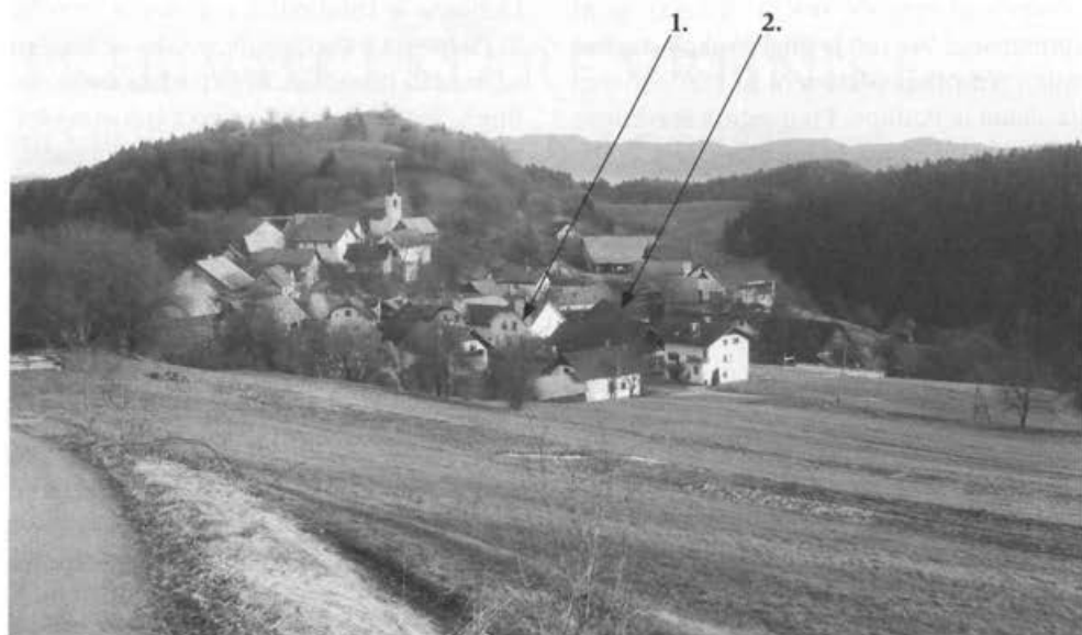
17. Žažar 2010, št. 1: lokacija šole, zgrajene ok. leta 1927, št. 2: prva lokacija šole, ki je danes v ruševinah (foto Janko Mole).
