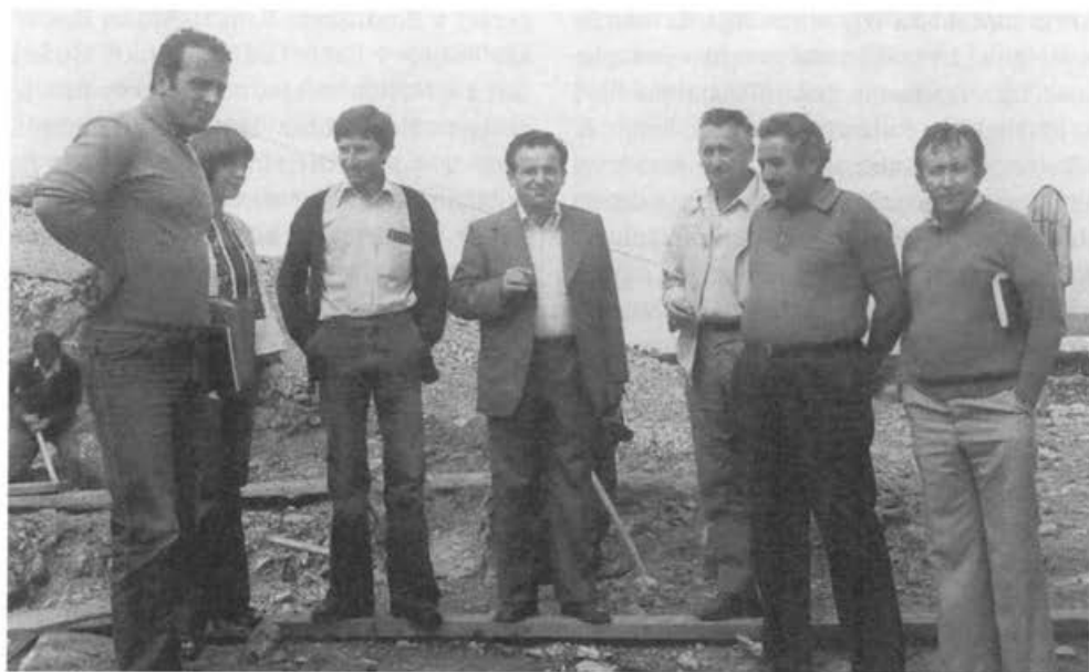
59. Inž. Jože Coren (v sredini fotografije) na gradbišču na Lovčenu, Črna gora, 1975. leta.
