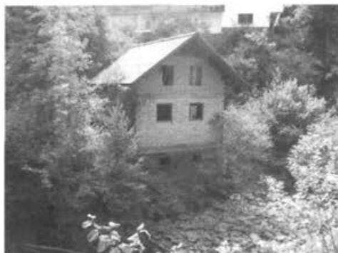
88. Sopot pri Rovtah, nadzidana stavba mlina.
