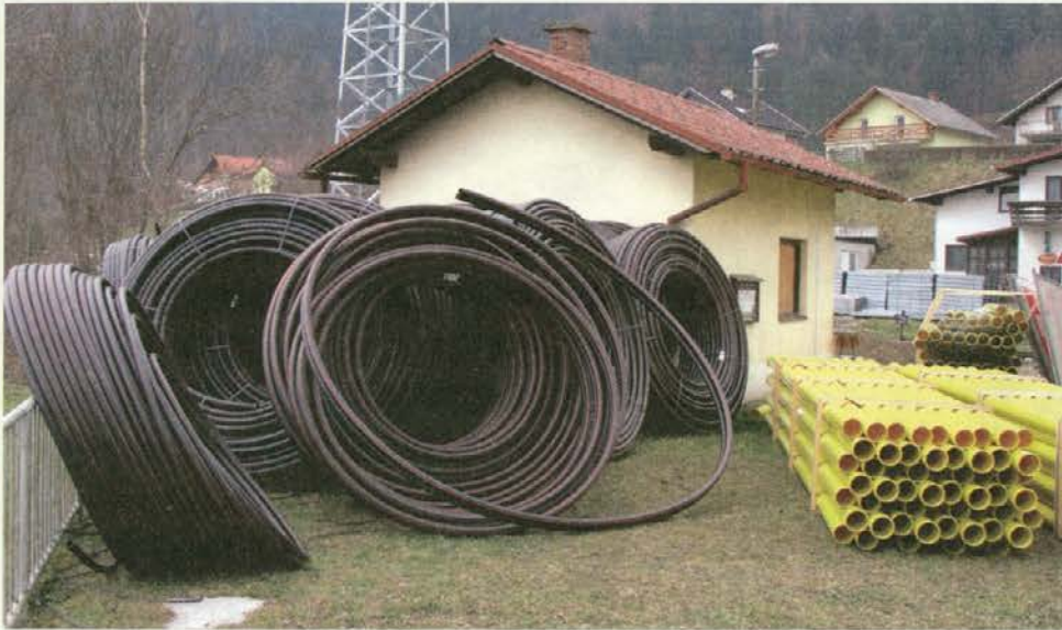
Pripravljen material za vgradnjo kablov
