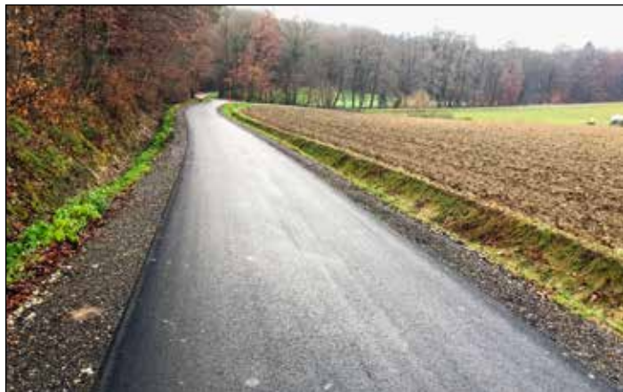
Obnova ceste v Šalovcih
