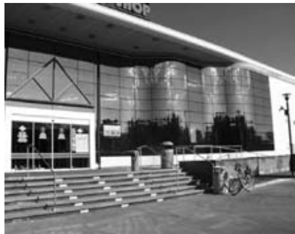
Slika 3b: strukturalna zasteklitev objekt Duty Free (Schüco, sistem SG 50 N)
