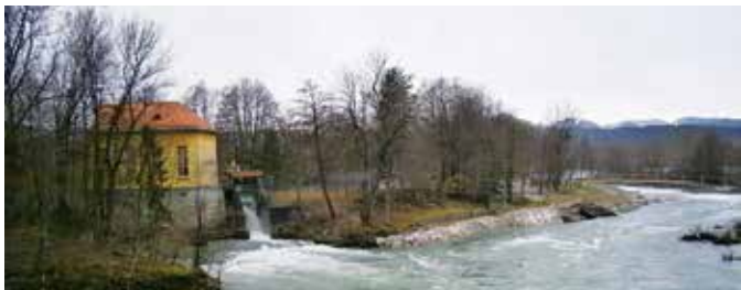
Pogled na elektrarno s Tacenskega mostu
