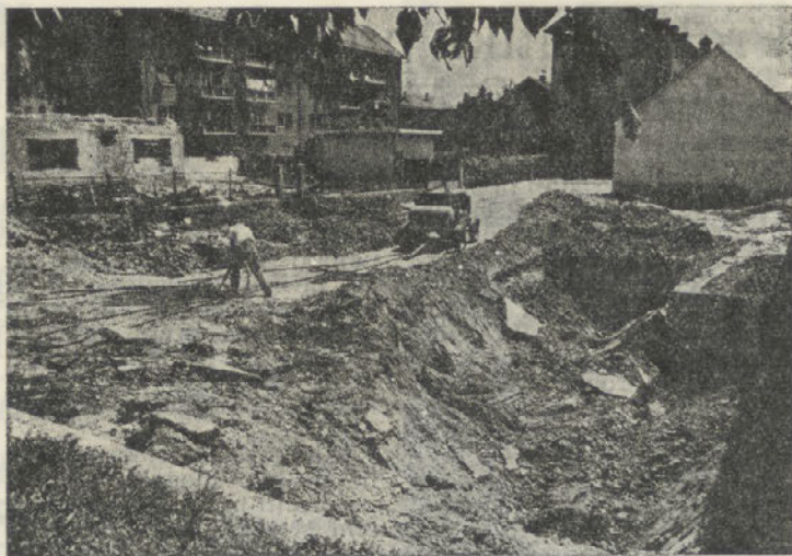
Priprava terena za novo upravno zgradbo
