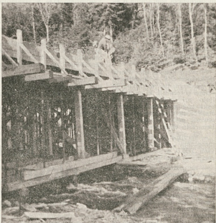
Priprave za betoniranje mostne plošče
