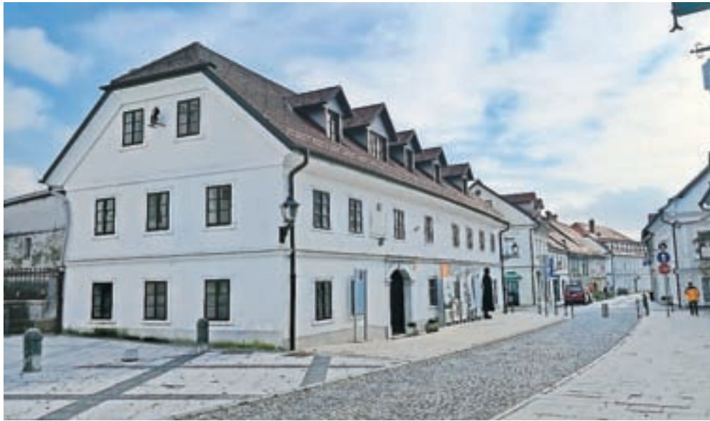
Z obnovo pritličja bo Maistrova rojstna hiša obiskovalcem ponudila boljši vpogled v zasnovo hiše, muzeju pa zagotovila dodaten prostor, ki ga nujno potrebuje. / FOTO: JASNA PALADIN
