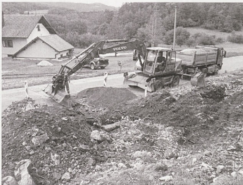
Gradnja vodovoda na Malo polje. Foto: Luka Bizjak
