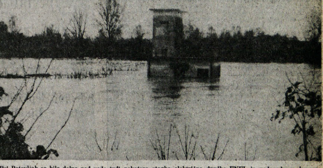
Pri Petovljah so bile delno pod vodo tudi nekatere stavbe električne družbe ENEL in vodovodnega konzorcija CAFO. Naprave v obeh stavbah so utrpeli precej škode
