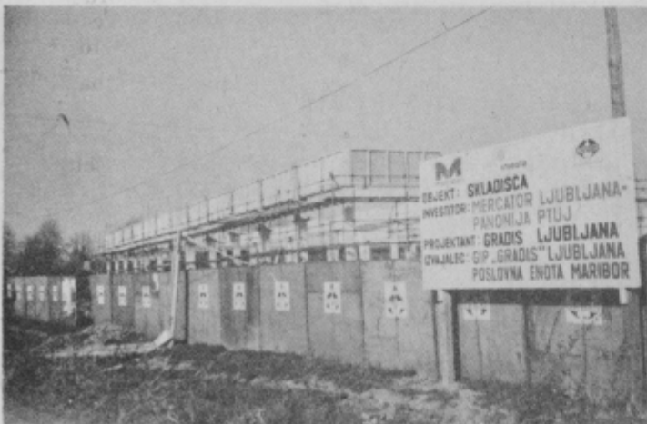
Gradnja novega skladišča „Panonije“
