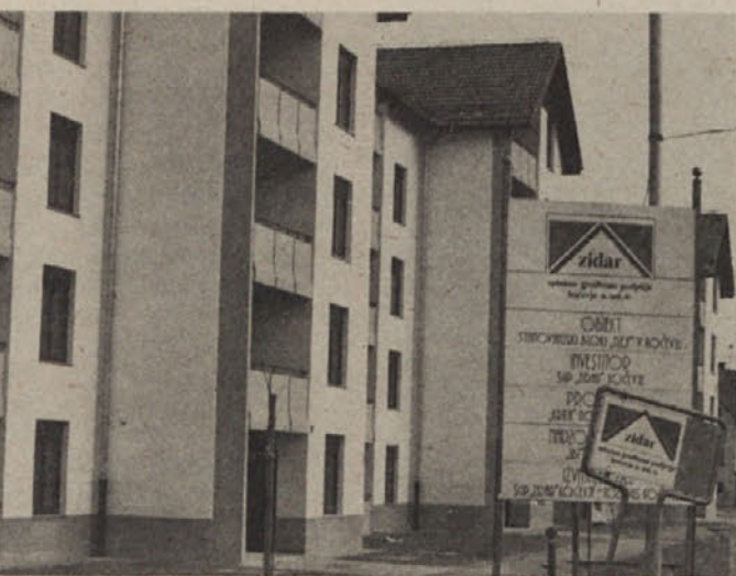
Delavci SGP Zidar so v kratkem času (7—8 mesecev) zgradili novih 55 stanovanj v ulici heroja Marinclja. V blokih D, E, F s stanovanjsko površino preko 3.000 m 2 stane dvosobno stanovanje okoli 180 milijonov din. V začetku tega meseca še ni bilo prodanih 20 stanovanj (foto: P. Š.)
