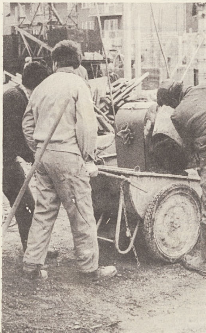
Beton je pripravljen
