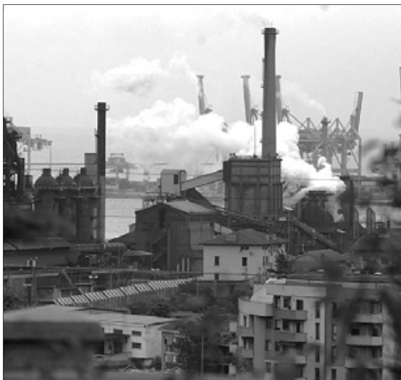
Pogled na škedenjsko železarno
