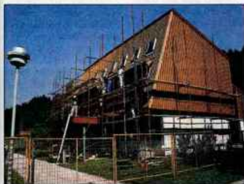
Dela pri obnovi strehe na šoli v Selcih so se že začela.
