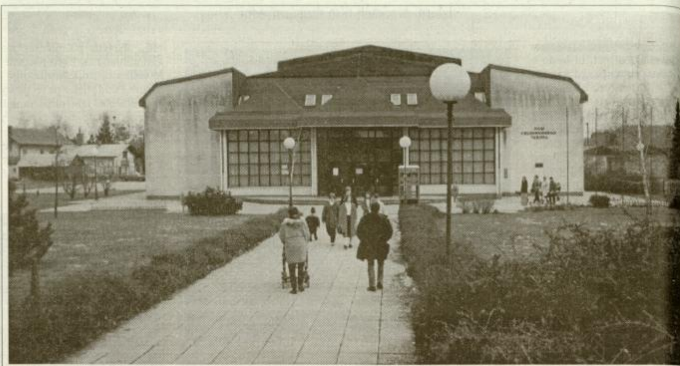
Zaradi slabo opravljenega dela se tožba proti izvajalcu žalskega kulturnega doma vleče že 12 let. Bo končno kdo tudi odgovarjal?
