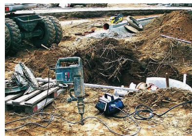
Slika 8: Po nekaterih statistikah so glede nezgod z električnim udarom kritična zlasti manjša gradbišča. Zaradi neugodnih razmer je tu vedno obvezna uporaba zaščitnih stikal na diferenčni tok kljub uporabi orodja razreda II. Če na razpolago ni ustreznih gradbenih razdelilnih omar, si lahko pomagamo s prenosnimi stikali PRCD. (Vir: www.kopp-ag.de )
