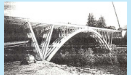
□ Slika 15. Holz-Europabrücke čez Muro v Avstriji med gradnjo (1992) /5/
