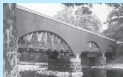
□ Sliki 6, 7. Most za pešce čez reko Tar v Skalnem gorovju in akvadukt Tohickon v Pennsilvaniji (2002) /2/
