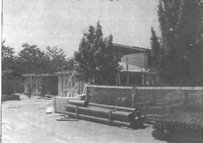
Zidovi na vzhodni strani že kažejo obris novega prizidka.
