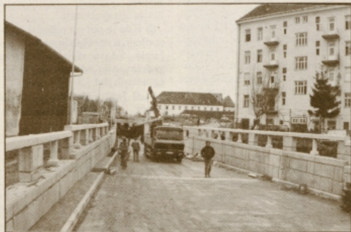
Gradnja podvoza je v sklepni etapi
