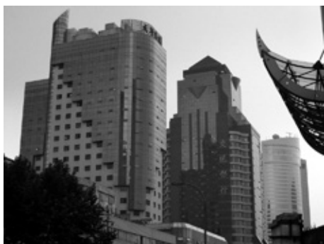
Bančne zgradbe na Kitajskem.
