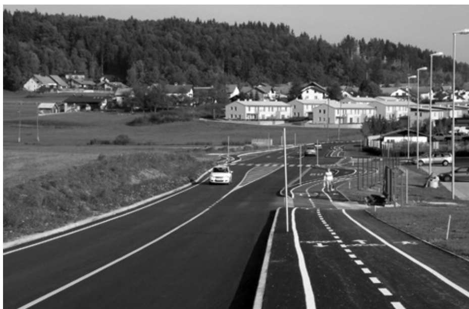
Skoraj dokončana cesta od Cikave do Brvac.
