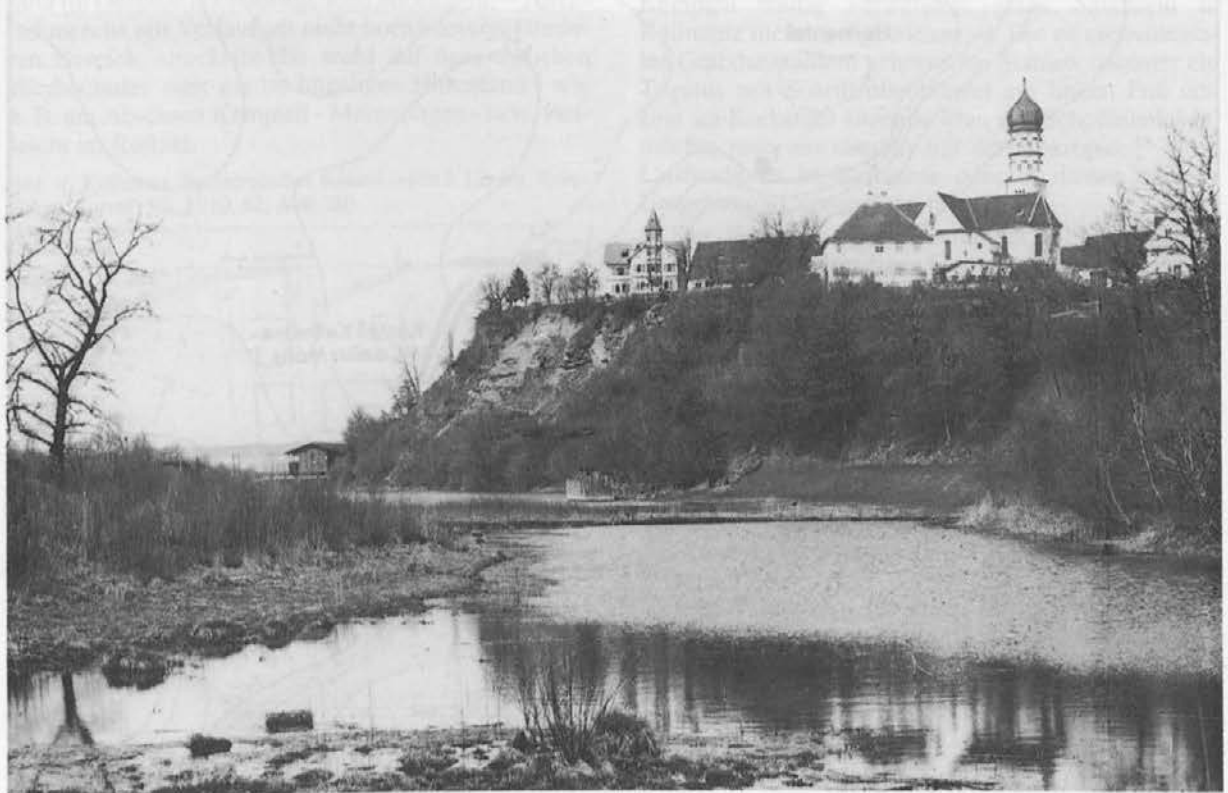
Abb. 2: Kellmünz. Plateau mit Pfarrkirche St. Martin und Steilabfall nach Süden und Südwesten um 1910 (nach J. Linder, Die Reste des römischen Kellmünz [1914] Taf. 1).
