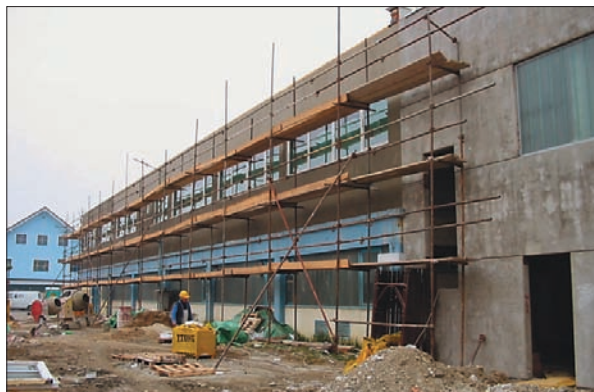
Objekt podjetja Goja, d.o.o., Ptuj med gradnjo ...
