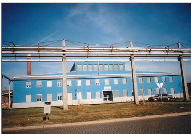
Nova hala elektrolize Taluma Kidričevo
