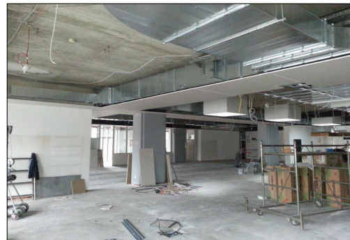
Slika 5: Montaža novih prezračevalnih kanalov. (Foto: Borut Gaber, UKM)
