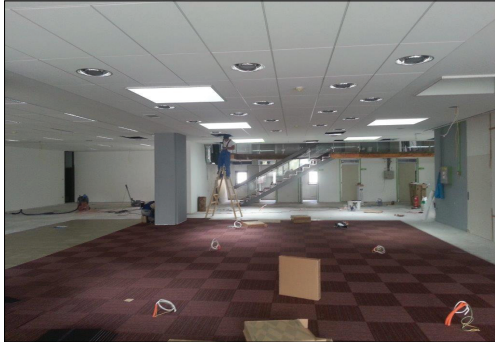
Slika 6: Montaža svetil in polaganje talnih oblog. (Foto: Borut Gaber, UKM)
