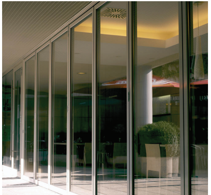
Slika 2. Zasteklitev do tal ob pohodni površini.
