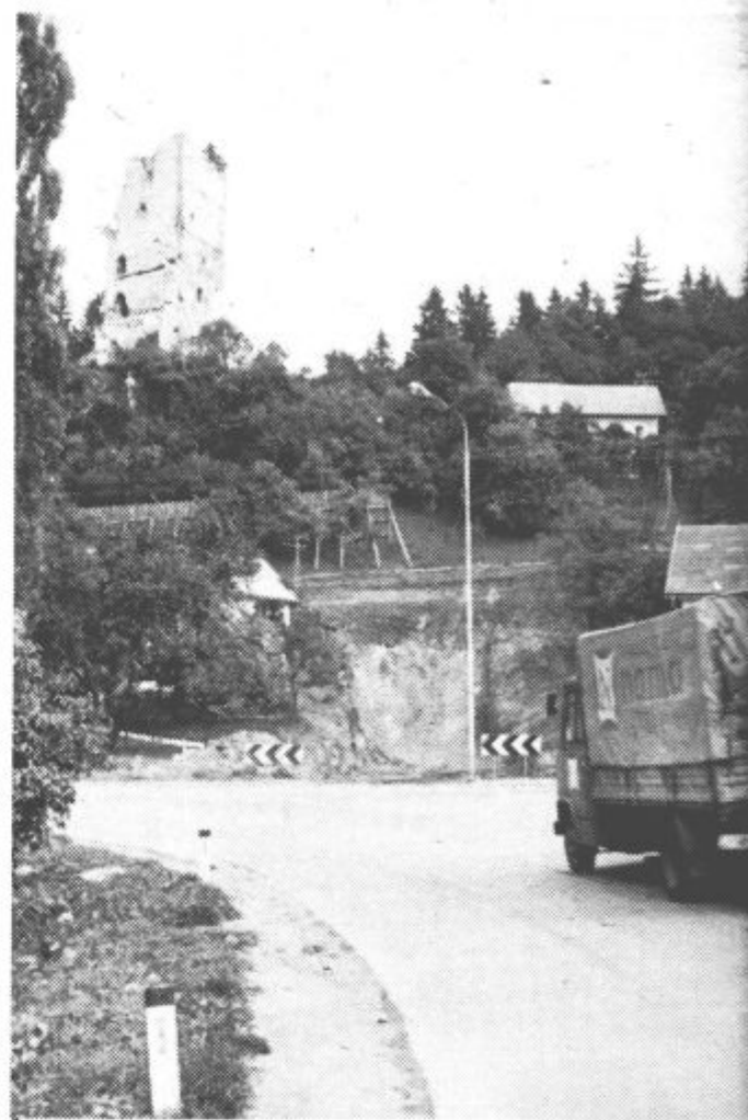
Dela na cesti Šalek-Selo dobro napredujejo. Pred dnevi so začeli kopati zemljo s stroji na zahodni strani stolpa Šaleškega gradu. Z izgradnjo ceste in predora bodo vozniki rešeni ostrega ovinka v Šaleku, Šalečani bodo lahko bolj varno hodili po središču vasi s prestavitvijo ceste pa bomo dobili tudi dodatne površine za blokovno stanovanjsko gradnjo.
