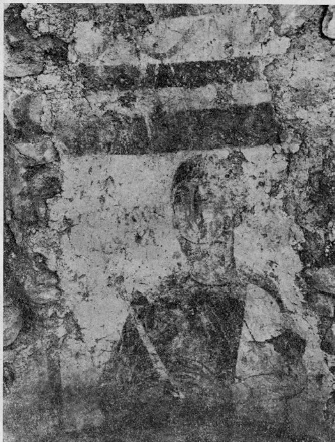
Fig. 13. Dvograd, basilica di S. Sofia; dipinto murale facente parte all'absidiola settentrionale, fase edilizia preromanica Sl. 13. Zidne slike u sjevernoj apsidioli predromaničke faze izgradnje bazilike Sv. Sofije u Dvogradu
