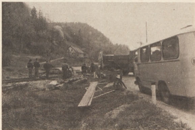
Urejanje prehoda čez železniško progno pri Otiškem vrhu.
