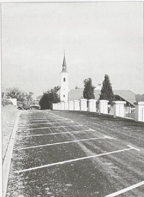
Ob pokopališču je že urejeno parkirišče
