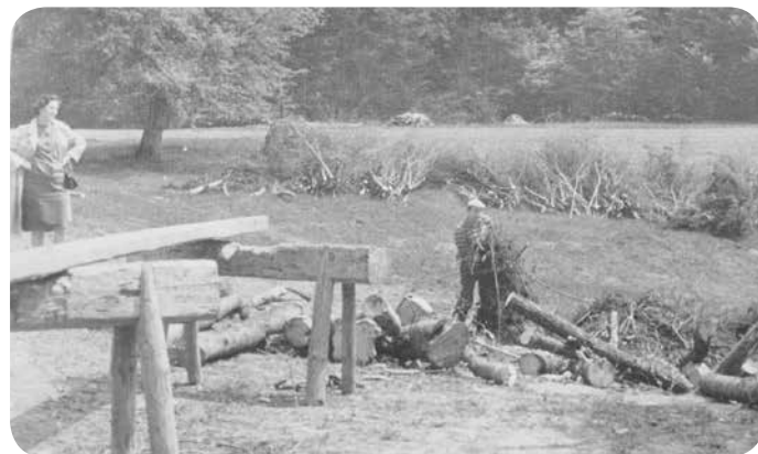
Priprava drv in frate za kurjenje četrte Bucovarjeve in zadnje predolske poljske apnenice. Gorela je od 6. do 13. maja leta 1967. Na sliki desno kurjač Povletov Alojz Fink iz Velike Račne pri Grosupljem; lastnica izvirne fotografije Marija Nučič, Predole št. 10
