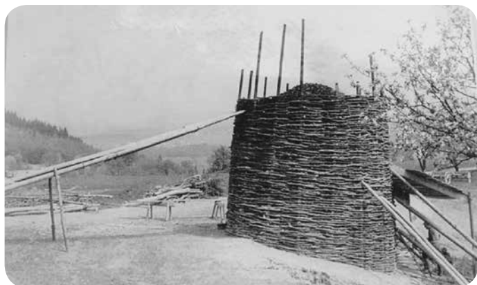
Bucovarjeva poljska apnenica s podpornimi koli in "gruštom"; lastnica izvirne fotografije Marija Nučič, Predole št. 10
