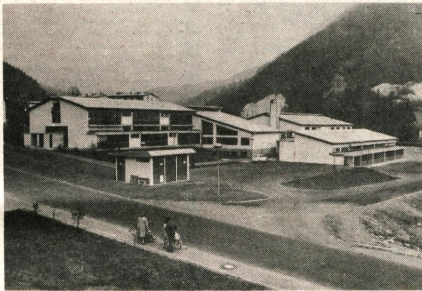
Nova osnovna šola heroja Bračiča v Bistrici pri Tržiču je eden od družbeno pomembnih objektov v občini, ki ga je zgradilo Splošno gradbeno podjetje Tržič. — Foto: F. Perdan
