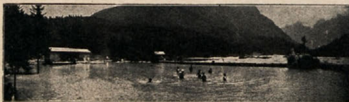
Kopališče „Jasna“ v Kranjski gori, ki se sedaj na novo gradi
