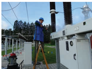
» Slika 4: Čiščenje z vodno paro v elektrarni.
