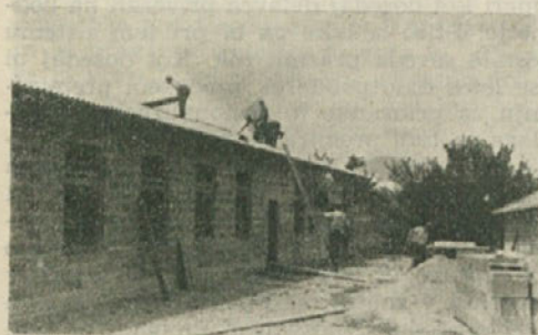
Nova delavska menza v Velenju med gradnjo
