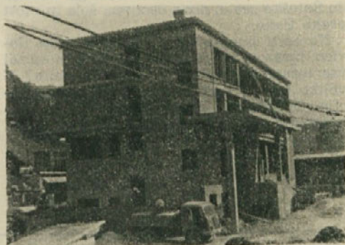
Gradnja poštnega poslopja v Trbovljah
