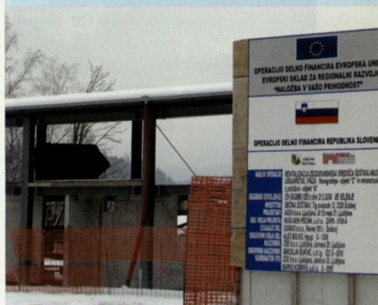
Pogled proti objektu C z južne strani; desno gradbiščna tabla (Foto: občina)
