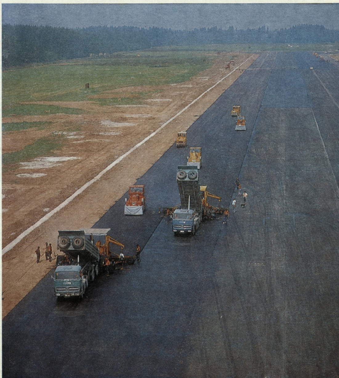
Rekonstrukcija letališča Brnik od 1. 7. do 31. 8. 1978 Asfaltiranje vzletno pristajalne steze (142.000 ton asfalta) Izvajalec SGP »SLOVENIJA CESTE« — Ljubljana Foto: P. Strnad
