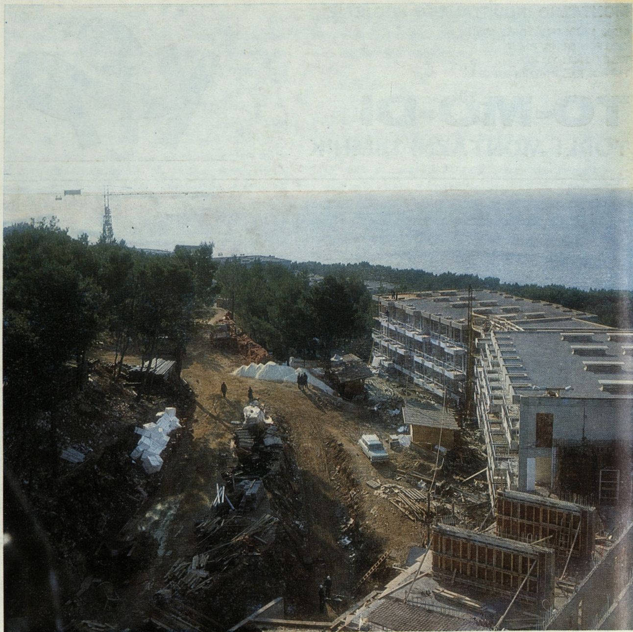
Lansko največje Pionirjevo gradbišče v Jugoslaviji: HOTELSKI KOMPLEKS SUNČANE UVALE na Malem Lošinju Foto: T. Vovko
