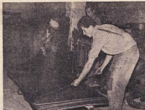
O pomanjkanju prostora govori tudi posnetek iz skladišča z gradbenim materialom
