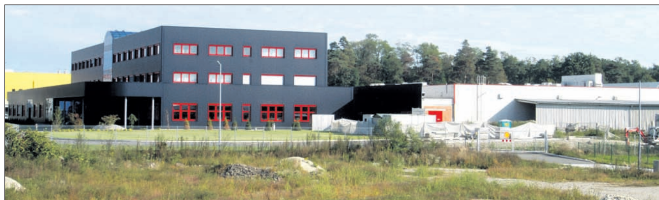
Širitev proizvodnih prostorov načrtujejo južno od obstoječe proizvodne hale v Kidričevem, na posnetku desno od razvojnega centra.
