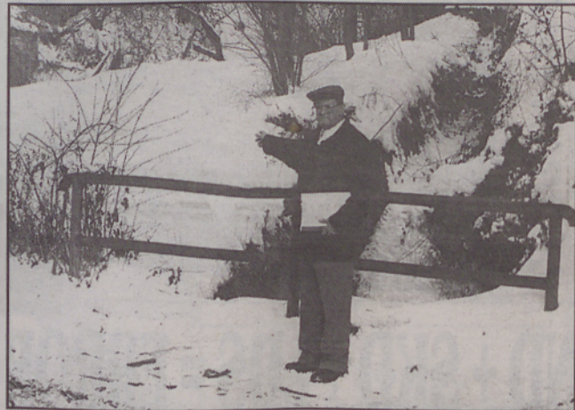
V grobi beton zajet Banffyjev izvir ob Hadikovi poti
