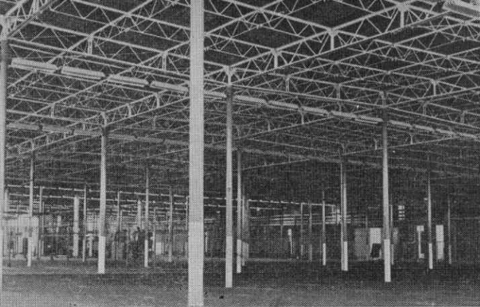
Dela na montažni hall tovarne v Velenju
