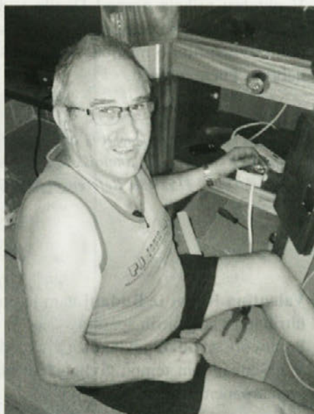
Izdelava instalacije v omarici za ozvočenje.
