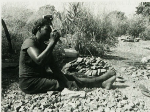
Tolčenje granita za mešanje med beton.
